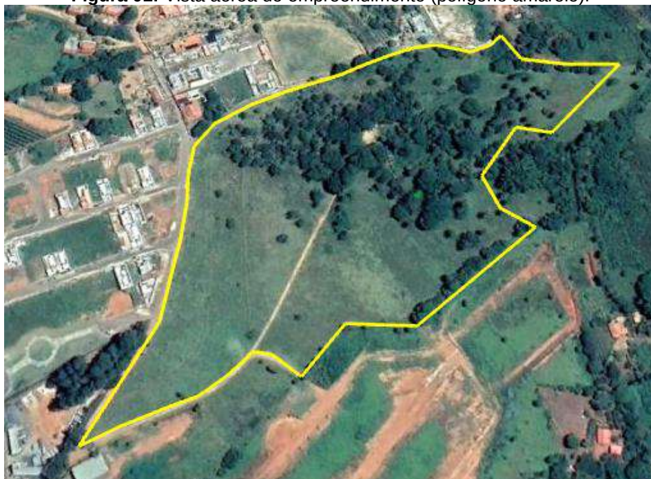
Figura 01: Vista aérea do empreendimento (polígono amarelo).
