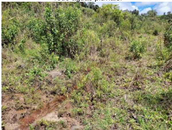
Figura 08: Área de intervenção em APP passagem rede águas pluviais.
